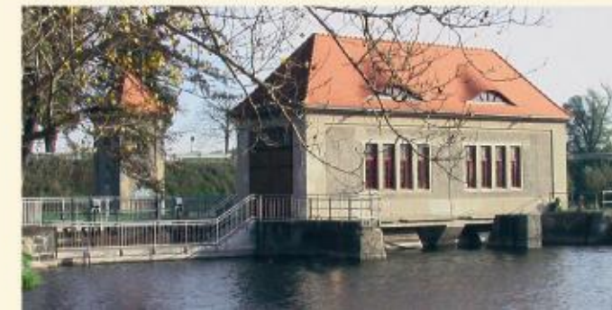
Paretzer Schleuse mit Pumpenhaus Restauriert 2004 - 2006
